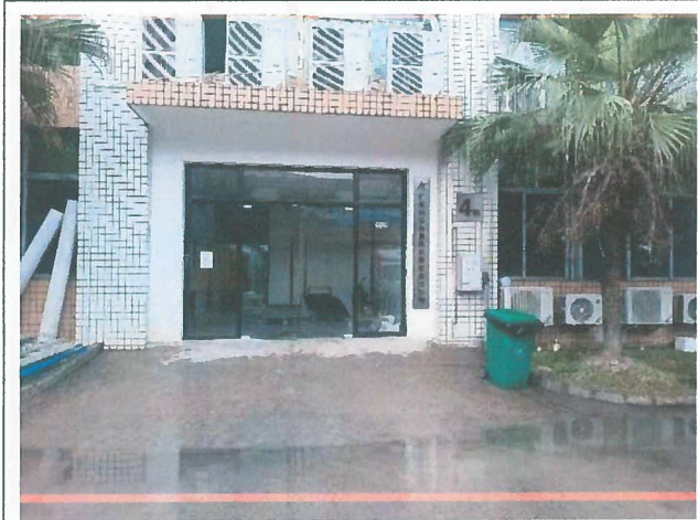
项目西面——园区厂房
