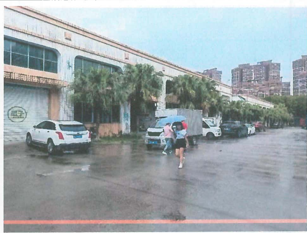
项目北面——园区厂房
