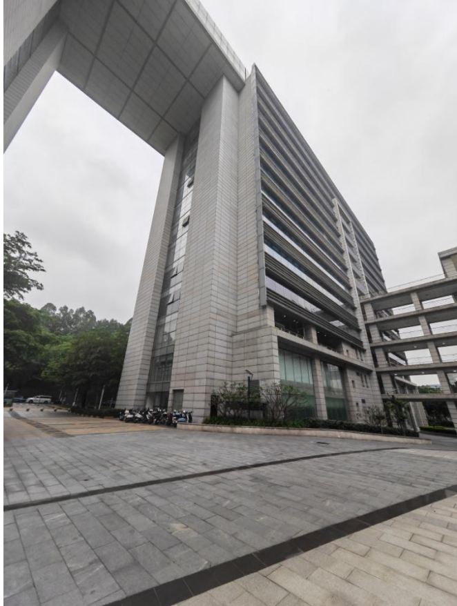
项目东北面：创新大厦 C2 栋
